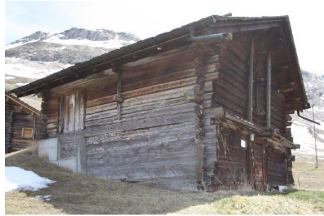
Gestrickte Stallscheune Teilweise Unterfangung aus Beton. Talfassade verstärkt.
