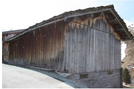
Gestrickte Stallscheune - Oberbau mit vertikaler Holzverschalung. Im südöstlicher Teil vertikale Erschliessung. Bestandteil einer Reihe (74, 80(WH), 80A, 80A-A und 84) charakteristischen Bauten.
