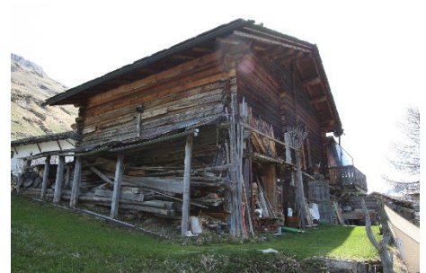
Gestrickte Stallscheune Anbau an Südostfassade (mit Wohnung/Atelier) und Vordach/Unterstand an Nordwestfassade störend.
