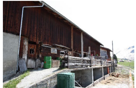
Gestrickte Stallscheune - Oberbau mit vertikaler Holzverschalung. Rampe und Podest aus Beton talseitig. Bestandteil einer Reihe (74, 80(WH), 80A, 80A-A und 84) charakteristischen Bauten.
