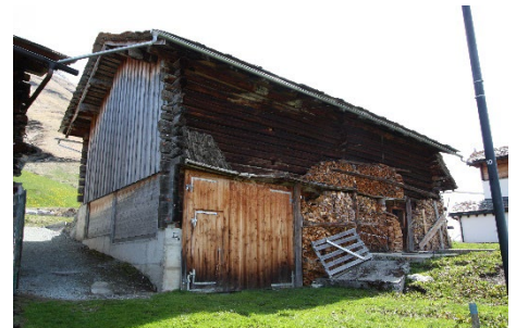
Gestrickte Stallscheune - An 89 angebaut. Oberbau mit vertikaler Holzverschalung. Teilweise Betonunterfangung. Rampe strassenseitig. Garagentore im Unter- und Erdgeschoss störend.
