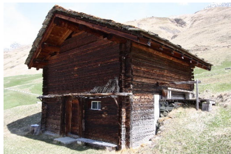
Gestrickte Stallscheune Teilweise Unterfangung aus Beton.
