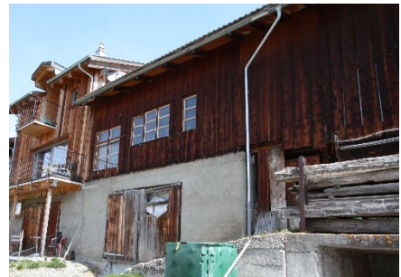
Gestrickte Stallscheune mit massivem Sockel - Oberbau mit vertikaler Holzverschalung. Öffnungen talseitig. Bestandteil einer Reihe (74, 80(WH), 80A, 80A-A und 84) charakteristischen Bauten.
