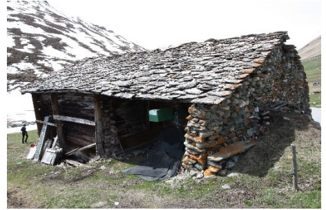
Gestrickte Stallscheune; Sehr kritischer baulicher Zustand. Anbau/Unterstand bergseitig einzigartig in der Gemeinde. Ursprüngliche Dachbedeckung mit Steinplatten und Strickbauweise.
