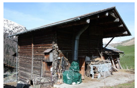
Gestrickte Stallscheune An 129A angebaut. Sehr stark verändert (Erhöhung, Vordach und Laube).
