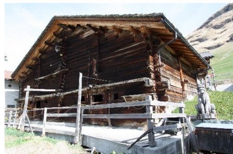
Gestrickte Stallscheune Neuer Steinplattendach. Teilweise Unterfangung aus Beton. Vorplatz talseitig betoniert.
