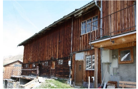
Gestrickte Stallscheune - Oberbau mit vertikaler Holzverschalung. Im südöstlicher Teil vertikale Erschliessung. Bestandteil einer Reihe (74, 80(WH), 80A, 80A-A und 84) charakteristischen Bauten.
