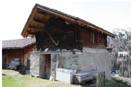
Gestricke Stallscheune mit gemauertem Sockel - Ehemaliges «Wäschhüttli». Sockel «rasapietra» verputzt. Verschiedene Festeröffnungen. Holztreppe an der Südostfassade.
