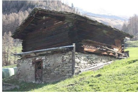
Gestrickte Stallscheune mit gemauertem Sockel Ausserhalb der Hauptsiedlung von Cröt. Sockel unterhaltsbedürftig.
