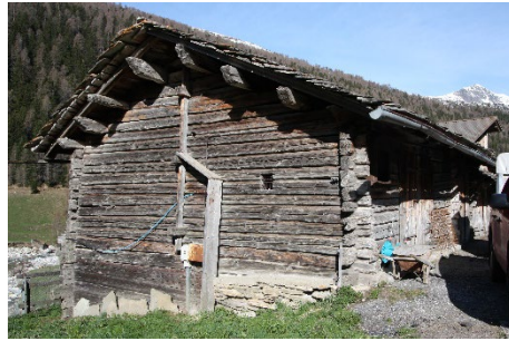
Gestrickte Stallscheune Gebäudeteil mit vertikaler Brettverschalung zwischen 199 und 200 nachträglich aufgestellt.
