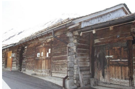
Gestrickte Stallscheune – An 36/37 angebaut. Teilweise Betonunterfangung. Atypische Eindeckung mit Malenco-Platten. Bestandteil einer Reihe (31, 32, 33, 34, 35, 36 und 37) charakteristischen Bauten.
