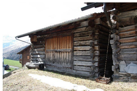
Gestrickte Stallscheune - Bestandteil (südöstlicher Kopfbau) einer Reihe (114, 115, 116 und 117) sehr gut erhaltenen und prominent gelegenen Ökonomiebauten an der Hauptstrasse. Ziegeldach.
