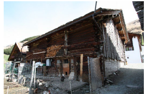
Gestrickte Stallscheune An 91 angebaut. Betonsockel strassenseitig. Vertikale Holzverschalung bei Oberbau an Südostfassade.
