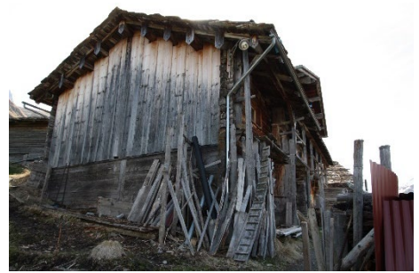
Gestrickte Stallscheune An 129 angebaut. Stark verändert (Verschalung, Fensteröffnung und Laube).
