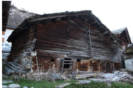
Gestrickte Stallscheune – Dach und Strickkonstruktion im Allgemeinen und insbesondere an Südfassade in sehr schlechtem baulichem Zustand.
