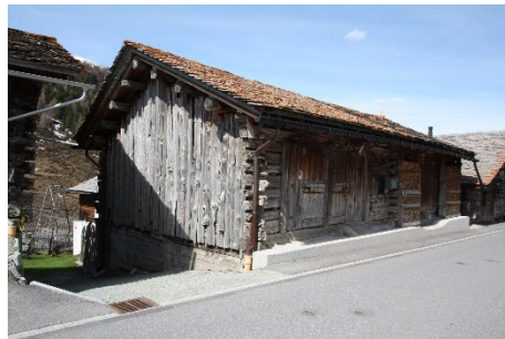
Gestrickte Stallscheune An 91 angebaut. Betonsockel strassenseitig. Vertikale Holzverschalung bei Oberbau an Südostfassade.
