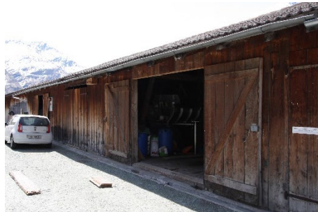
Gestrickte Stallscheune - Oberbau mit vertikaler Holzverschalung. Rampe und Podest aus Beton talseitig. Bestandteil einer Reihe (74, 80(WH), 80A, 80A-A und 84) charakteristischen Bauten.
