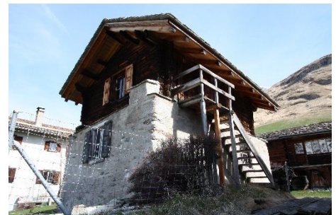
Gestricke Stallscheune mit gemauertem Sockel - Ehemaliges «Wäschhüttli». Sockel «rasapietra» verputzt. Verschiedene Festeröffnungen. Holztreppe an der Südostfassade.
