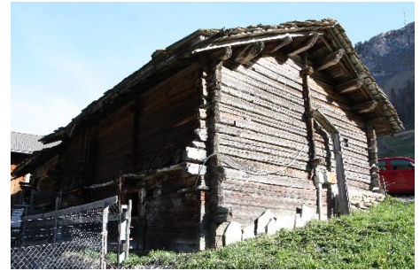
Gestrickte Stallscheune Gebäudeteil mit vertikaler Brettverschalung zwischen 199 und 200 nachträglich aufgestellt.
