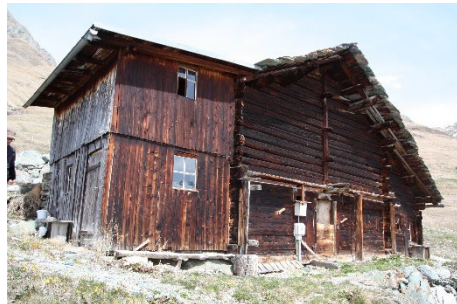
Gestrickte Stallscheune. Älterer Anbau an Ostfassade mit gemauertem Sockel. Neuzeitlicher Anbau an Westfassade störend. Bemerkung: Gefahrenzone 2.
