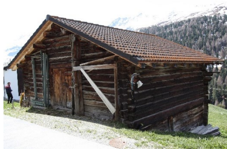
Gestrickte Stallscheune Anbau/Vordach an südöstlicher Fassade störend. Neue Dachkonstruktion und Eindeckung.
