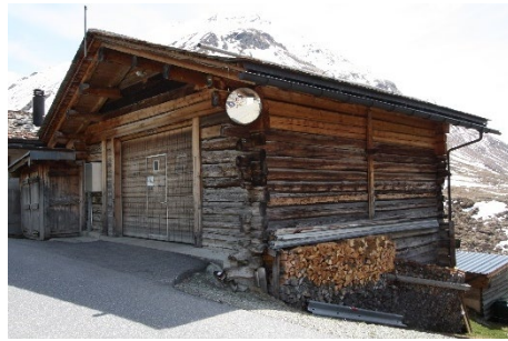
Gestrickte Stallscheune Rund 60 cm erhöht. Einbau Garagentor strassenseitig. Anbau an Südostfassade störend.
