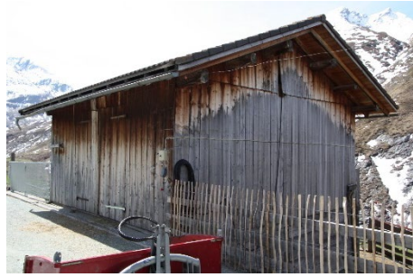
Gestricke Stallscheune Oberbau mit vertikaler Holzverschalung, Ziegeldach.
