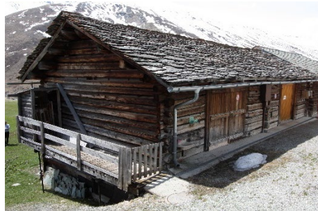
Gestrickte Stallscheune – Laube an Südostfassade. Bestandteil einer Reihe (31, 32, 33, 34, 35, 36 und 37) charakteristischen Bauten. Elektroverteiler an Strassenfassade störend.
