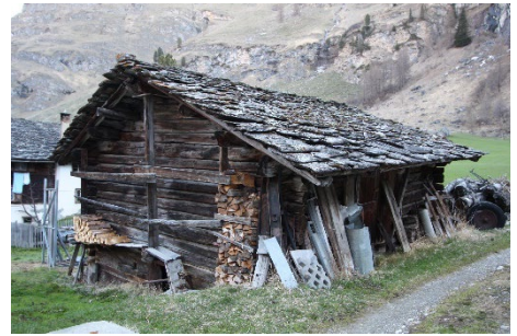
Gestrickte Stallscheune; Südwestliche Gebäudeecke in kritisch baulichem Zustand (Gebäudeecke kippt/sinkt). Bemerkung: Gefahrenzone 2.
