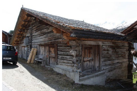
Gestrickte Stallscheune Neuer Steinplattendach. Teilweise Unterfangung aus Beton. Vorplatz talseitig betoniert.
