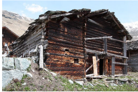
Gestrickte Stallscheune; Sehr kritischer baulicher Zustand. Anbau/Unterstand bergseitig einzigartig in der Gemeinde. Ursprüngliche Dachbedeckung mit Steinplatten und Strickbauweise.
