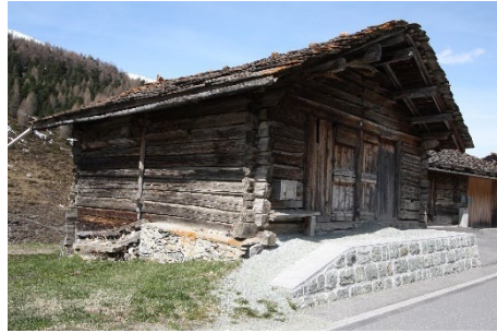
Gestrickte Stallscheune Teilweise gemauerte Unterfangung. Mauer strassenseitig. Dach sanierungsbedürftig.
