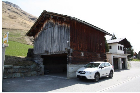
Gestrickte Stallscheune Ausserhalb der Bauzone. Stark verändert (Betonsockel, grosse Öffnung im UG und Tor bergseitig).
