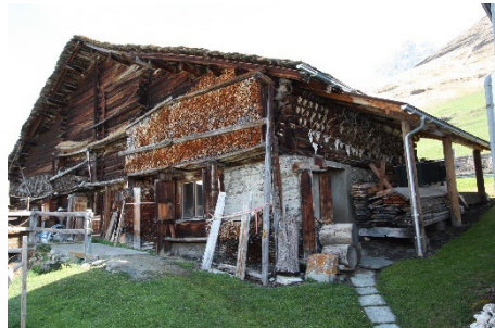
Gestrickte Stallscheune mit teilweise gemauertem Sockel - An 127-B angebaut. Fensteröffnungen im Untergeschoss nachträglich erstellt. Vordächer/Anbauten bergseitig störend.
