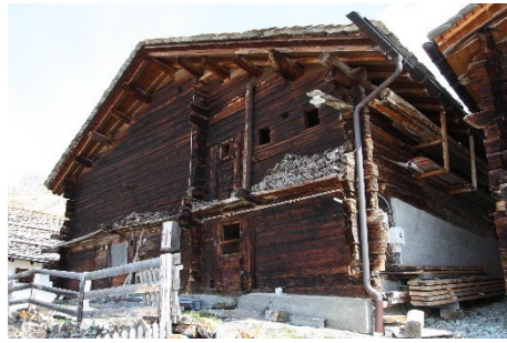
Gestricke Stallscheune Teilweise Unterfangung aus Beton.
