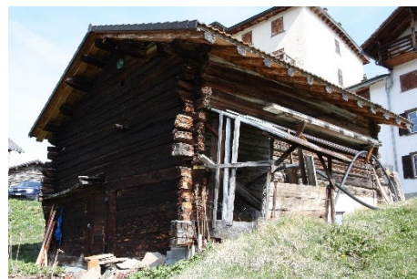
Gestrickte Stallscheune Anbau/Vordach an südöstlicher Fassade störend. Neue Dachkonstruktion und Eindeckung.
