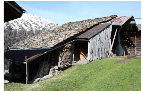
Gestrickte Stallscheune mit teilweise gemauertem Sockel - An 127-B angebaut. Fensteröffnungen im Untergeschoss nachträglich erstellt. Vordächer/Anbauten bergseitig störend.
