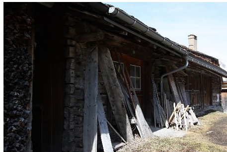
Gestrickte Stallscheune - Bestandteil einer Reihe (114, 115, 116 und 117) sehr gut erhaltenen und prominent gelegenen Ökonomiebauten an der Hauptstrasse.
