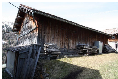
Gestrickte Stallscheune - Oberbau mit vertikaler Holzverschalung nachträglich verkleidet. Teilweise Betonunterfangung. Betonierter Vorplatz talseitig (mit Hot Pot).
