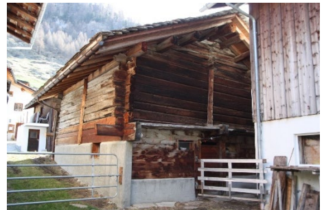
Gestrickte Stallscheune - Strassenseitige Treppe und Sockel (teilweise) neu in Beton erstellt. Dach inkl. Holzkonstruktion kürzlich ersetzt.
