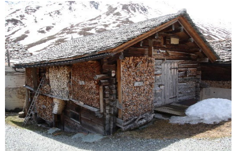
Gestrickte Stallscheune Atypischer Vorplatz mit Betonplatten talseitig. Laube talseitig. Steinplattendach neu.
