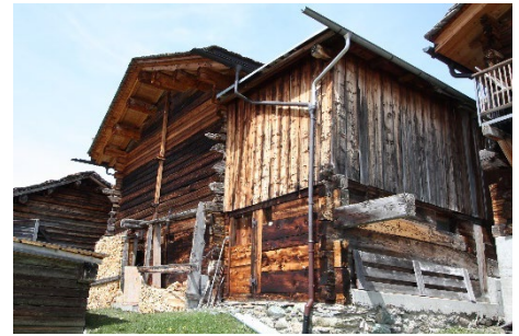
Gestrickte Stallscheune Rund 60 cm erhöht. Einbau Garagentor strassenseitig. Anbau an Südostfassade störend.
