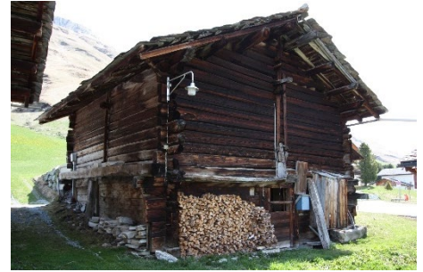
Gestrickte Stallscheune Teilweise gemauerte Unterfangung. Mauer strassenseitig. Dach sanierungsbedürftig.
