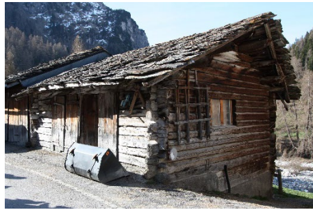
Gestrickte Stallscheune Verschiedene Fensteröffnungen nachträglich ausgeschnitten.
