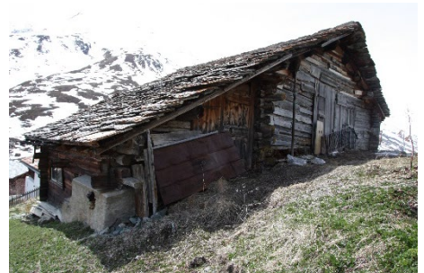
Gestrickte Stallscheune. Älterer Anbau an Ostfassade mit gemauertem Sockel. Neuzeitlicher Anbau an Westfassade störend. Bemerkung: Gefahrenzone 2.
