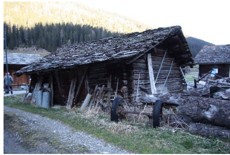
Gestrickte Stallscheune; Südwestliche Gebäudeecke in kritisch baulichem Zustand (Gebäudeecke kippt/sinkt). Bemerkung: Gefahrenzone 2.
