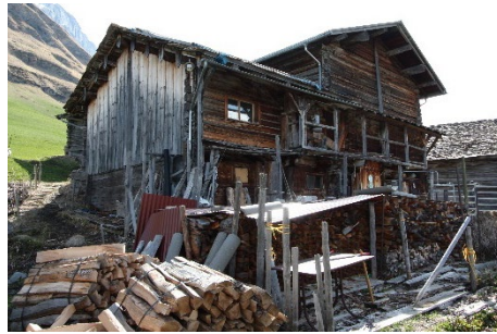
Gestrickte Stallscheune An 129 angebaut. Stark verändert (Verschalung, Fensteröffnung und Laube).
