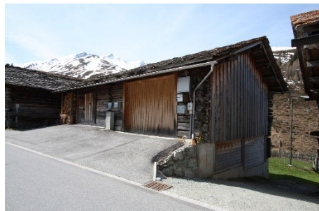
Gestrickte Stallscheune - An 89 angebaut. Oberbau mit vertikaler Holzverschalung. Teilweise Betonunterfangung. Rampe strassenseitig. Garagentore im Unter- und Erdgeschoss störend.
