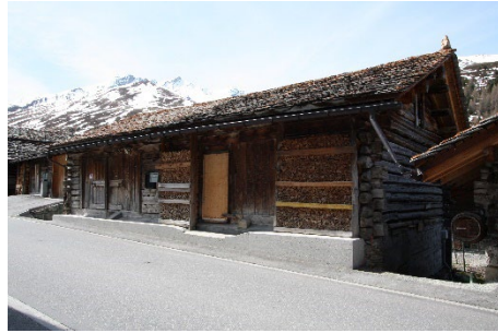
Gestrickte Stallscheune An 91A angebaut. Betonsockel strassenseitig.
