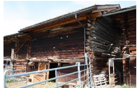
Gestrickte Stallscheune – An 36/37 angebaut. Teilweise Betonunterfangung. Atypische Eindeckung mit Malenco-Platten. Bestandteil einer Reihe (31, 32, 33, 34, 35, 36 und 37) charakteristischen Bauten.
