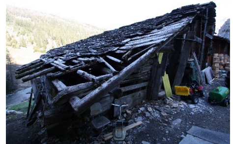
Gestrickte Stallscheune – Dach und Strickkonstruktion im Allgemeinen und insbesondere an Südfassade in sehr schlechtem baulichem Zustand.
