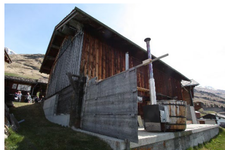
Gestrickte Stallscheune - Oberbau mit vertikaler Holzverschalung nachträglich verkleidet. Teilweise Betonunterfangung. Betonierter Vorplatz talseitig (mit Hot Pot).
