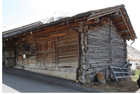
Gestrickte Stallscheune – Teilweise Unterfangung aus Beton. Wo jetzt Gebäude 36 steht, war früher ein Durchgang. Bestandteil einer Reihe (31, 32, 33, 34, 35, 36 und 37) charakteristischen Bauten.
