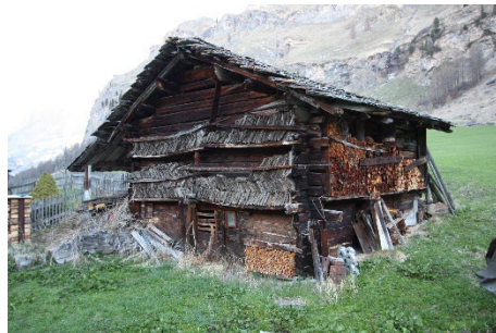
Gestrickte Stallscheune Unterstand an Nordfasse störend. Bemerkung: Gefahrenzone 2.
