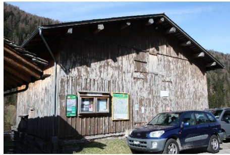
Stallscheune mit gemauertem Sockel Oberbau neu aufgestellt.
