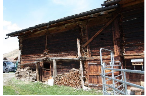
Gestrickte Stallscheune – Teilweise Unterfangung aus Beton. Wo jetzt Gebäude 36 steht, war früher ein Durchgang. Bestandteil einer Reihe (31, 32, 33, 34, 35, 36 und 37) charakteristischen Bauten.
