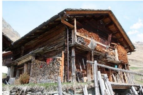
Gestrickte Stallscheune Atypischer Vorplatz mit Betonplatten talseitig. Laube talseitig. Steinplattendach neu.
