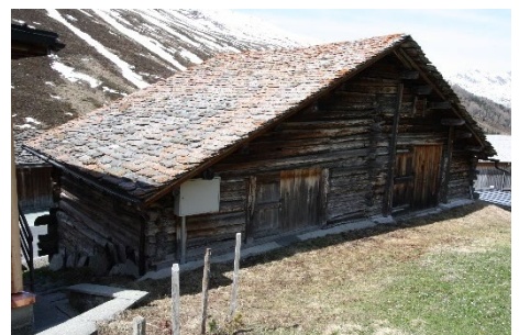
Gestrickte Doppelstallscheune Garagentor an Nordwestfassade störend. Teilweise Betonunterfangung.
