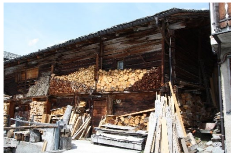
Gestrickte Stallscheune; An 16A (bereits zu Wohnzwecken umgenutzt) angebaut. Laube strassenseitig. Bemerkung: Gefahrenzone 2.
