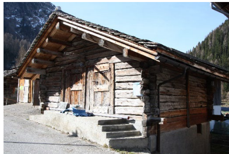
Gestrickte Stallscheune - Strassenseitige Treppe und Sockel (teilweise) neu in Beton erstellt. Dach inkl. Holzkonstruktion kürzlich ersetzt.
