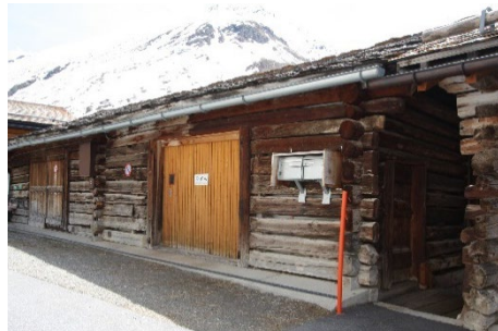
Gestrickte Stallscheune – An 33 angebaut. Gestaltung strassenseitiges Garagentor störend. Schiebetor talseitig atypisch. Bestandteil einer Reihe (31, 32, 33, 34, 35, 36 und 37) charakteristischen Bauten.
