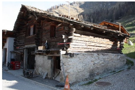
Gestrickte Stallscheune – Historischer Anbau im Südwesten mit gemauertem Sockel. Nachträglich eingebautes strassenseitiges Garagentor sowie Garagenanbau im Nordwesten störend.
