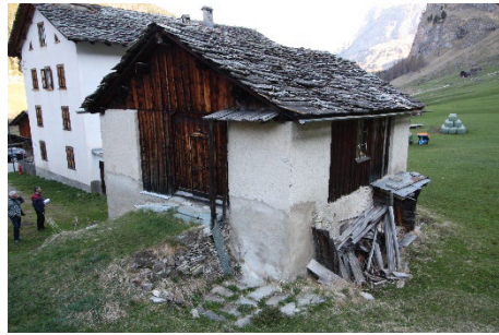
Eckpfeilerstallscheune – Kleine Anbauten an Ost- und Westfassade störend. Fenster an Ost-, Nord- und Westfassade nachträglich eingebaut.
