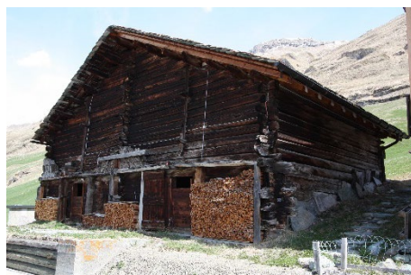
Gestrickte Doppelstallscheune Garagentor an Nordwestfassade störend. Teilweise Betonunterfangung.
