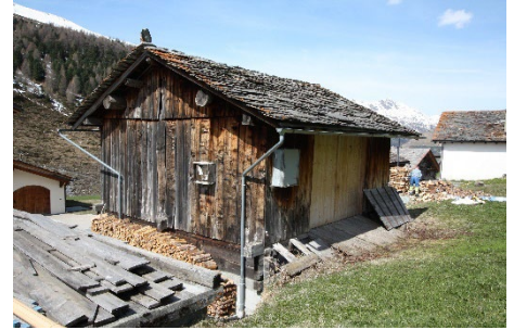
Gestrickte Stallscheune Ausserhalb der Bauzone. Stark verändert (Betonsockel, grosse Öffnung im UG und Tor bergseitig).
