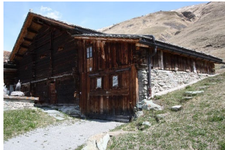
Gestrickte Stallscheune Passend renoviert (keine Wohnnutzung). Seitlicher Anbau mit gemauertem Sockel atypisch.
