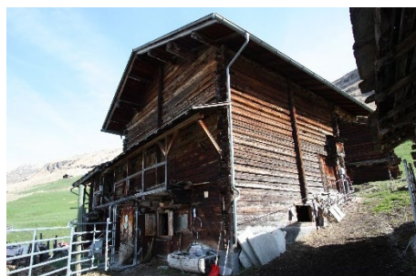
Gestrickte Stallscheune An 129A angebaut. Sehr stark verändert (Erhöhung, Vordach und Laube).
