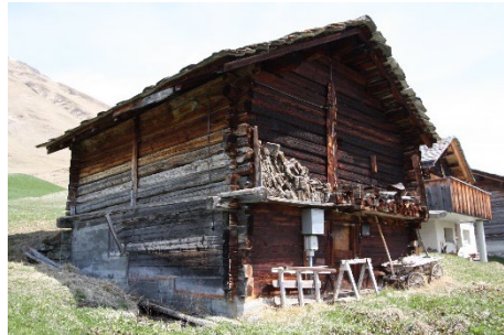
Gestrickte Stallscheune Teilweise Unterfangung aus Beton.
