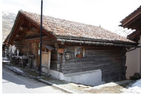
Gestricke Stallscheune Teilweise Unterfangung aus Beton. Verschiedene neue Öffnungen.
