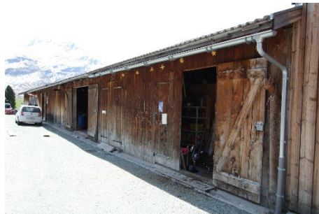
Gestrickte Stallscheune mit massivem Sockel - Oberbau mit vertikaler Holzverschalung. Öffnungen talseitig. Bestandteil einer Reihe (74, 80(WH), 80A, 80A-A und 84) charakteristischen Bauten.
