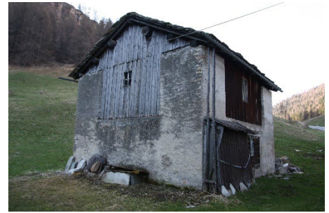
Eckpfeilerstallscheune – Kleine Anbauten an Ost- und Westfassade störend. Fenster an Ost-, Nord- und Westfassade nachträglich eingebaut.
